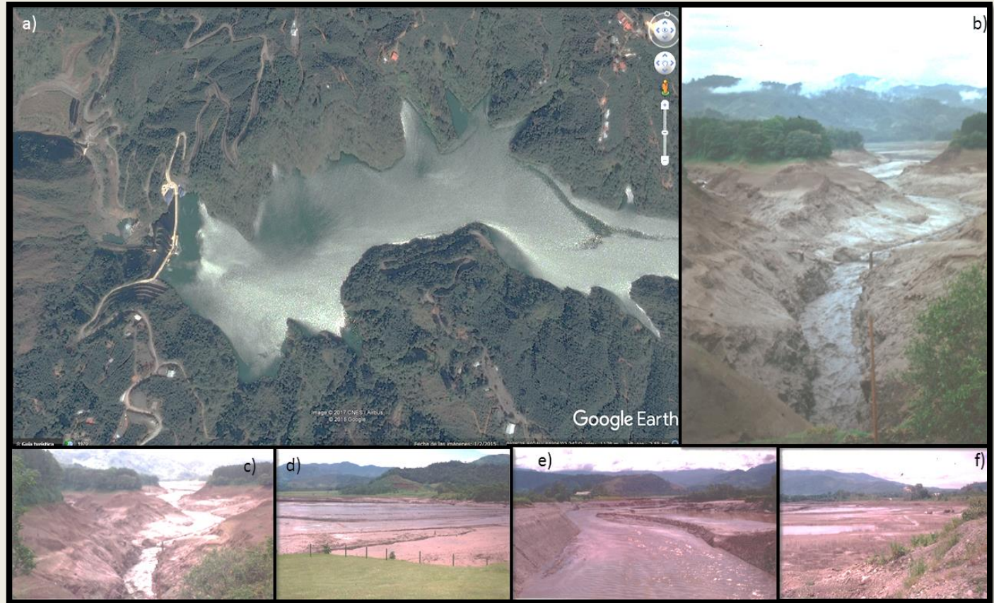
Represa Hidroeléctrica Pirrís: a) vista aérea; b – f) acumulación de sedimentos
